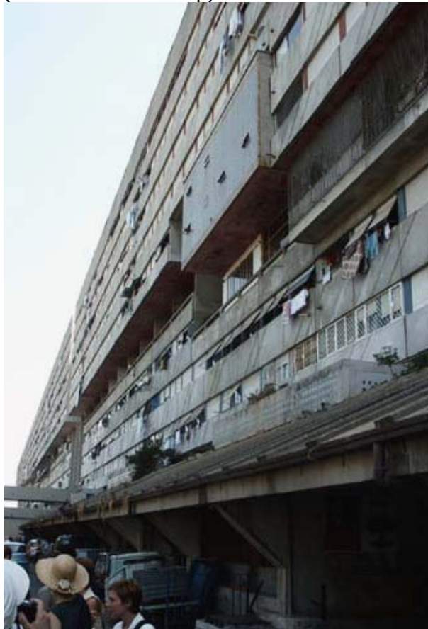
Abb. 2 Ansicht des neunstöckigen Hauptgebäudes von Corviale (Foto: Patricia Ehrkamp) Das neungeschossige, aus Beton errichtete Hauptgebäude hat eine Länge von einem Kilometer und beherbergt zwischen 4'500 und 8'800 Personen. Mietzahlungen richten sich nach dem Familieneinkommen. Die genauen Einwohnerzahlen sind wegen zahlreicher undokumentierter Bewohner und Bewohnerinnen nur schwer zu ermitteln. So ist etwa die gesamte vierte Etage, vom Architekten als Geschäftszeile vorgesehen, von Hausbesetzern zu zusätzlichen Wohnungen umfunktioniert worden. Die Strom- und Wasserversorgung für diese offiziell nicht vorhandenen Wohnungen wird kreativ und nicht immer ohne Konflikte zwischen den Betroffenen durch Verlängerungskabel aus legalen Wohnungen gelöst. Wie viele Massensiedlungen ist auch Corviale nicht von sozialen Problemen wie Armut und Drogenkonsum verschont geblieben, jedoch konnte letzterer durch die Einrichtung einer lokalen Polizeistation zumindest eingedämmt werden. Es muß allerdings betont werden, dass die Bewohner Corviales sich in ihrem Stadtteil wohl fühlen und ihre für Rom überdurchschnittlich großen Wohnungen nicht aufgeben wollen. Liebevoll mit Pflanzen gestaltete Flure gehören daher genauso zu diesem Stadtteil wie vernachlässigte Außenbereiche, Graffiti und Vorurteile gegenüber den Bewohnern und Bewohnerinnen.
